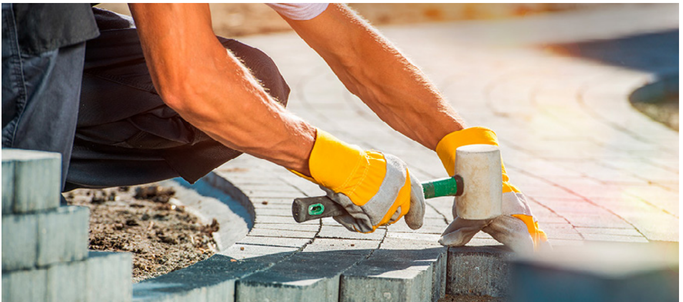
Bilder © EVB BauPunkt
